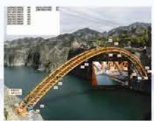
大跨度钢结构健康监测项目
