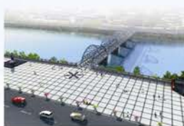
兰州市中桥顶升加固改造工程结构健康监测
