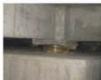
叠层橡胶支座隔震结构
